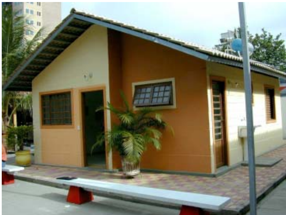
Figura 1 – Casa 1.0 construída por alunos na Escola SENAI “Orlando Laviero Ferraiuolo”
