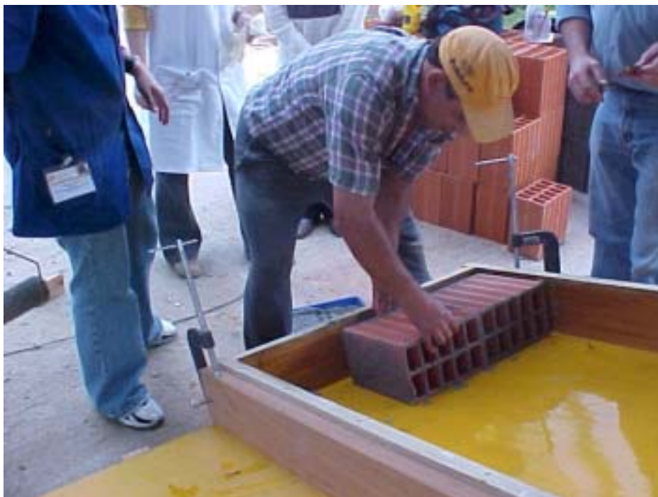
Ilustração 03 - Etapa de colocação dos blocos na fase de moldagem
