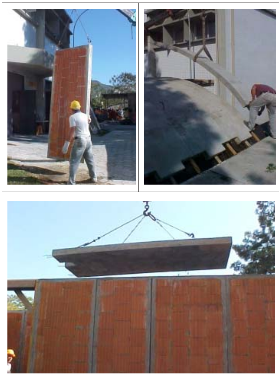
Ilustração 05 - Painel tipo parede, laje e curvo sendo içado durante a montagem.
