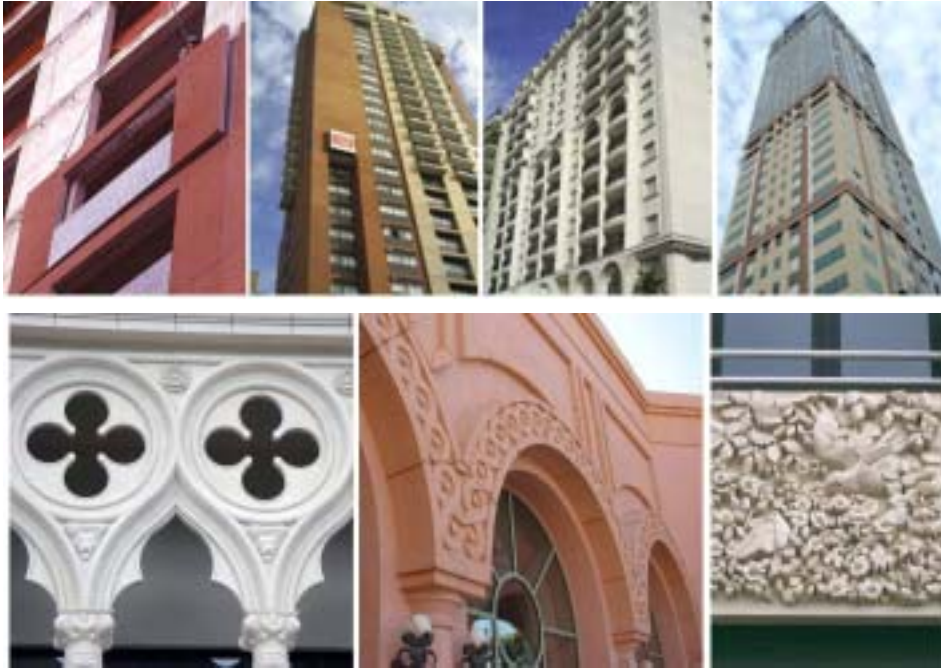
Detalhes de painéis em GRC
