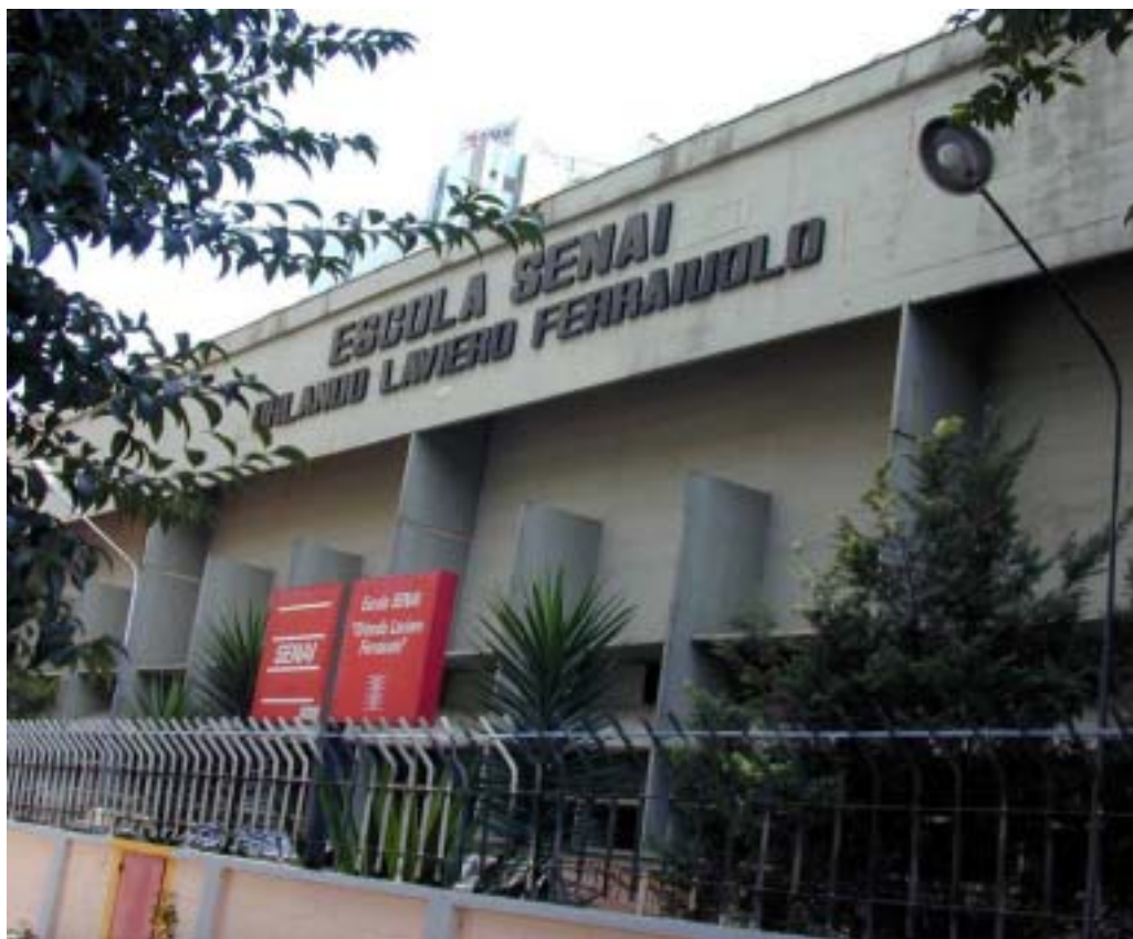
Figura 2 – Fachada da Escola SENAI “Orlando Laviero Ferraiuolo”
